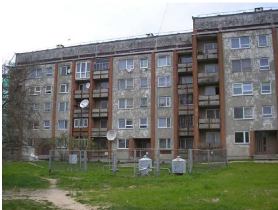
Jūras iela 21 vor der Wärmedämmung.....
