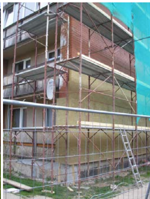
.....während der Arbeiten
